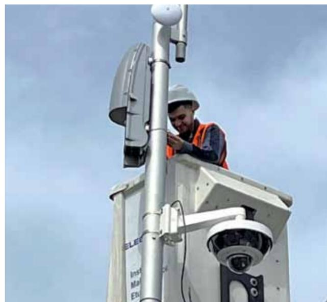
▲ Montage EPV4/5 mit Dome-Kamera und WLAN-Antenne
